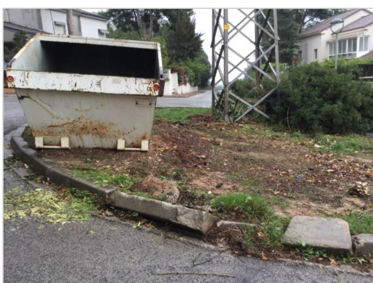
Imatges de zones en mal estat a la urbanització Solimar. Foto: Cedida
