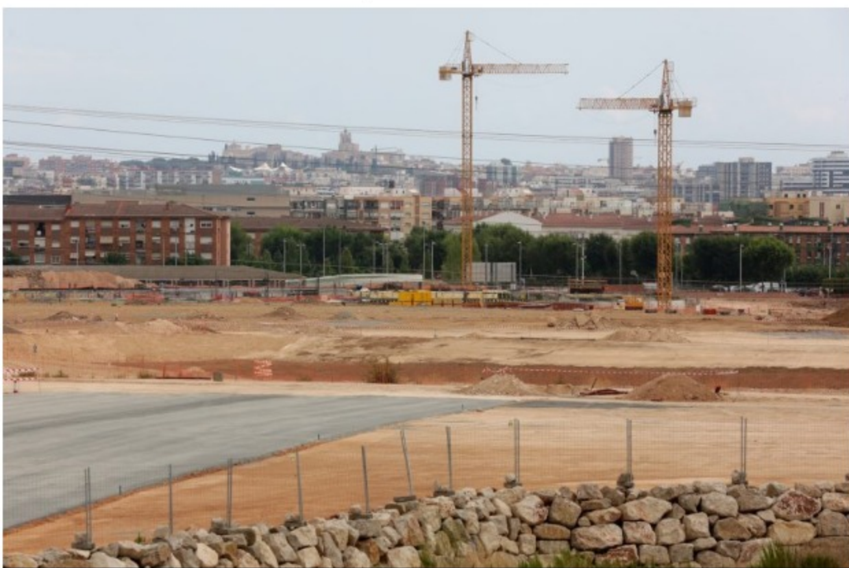
Imagen de ayer del aspecto que ofrecen las obras que se están realizando en el futuro Anillo Mediterráneo de los Juegos. Foto: Iuís milián
